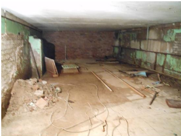
Рис. 1. Старение отделки и конструкций ЗС ГО
